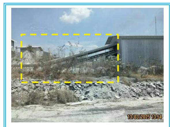
รูปที่ 3-15 ระบบสายพานลำเลียงแบบปิดคลุม
